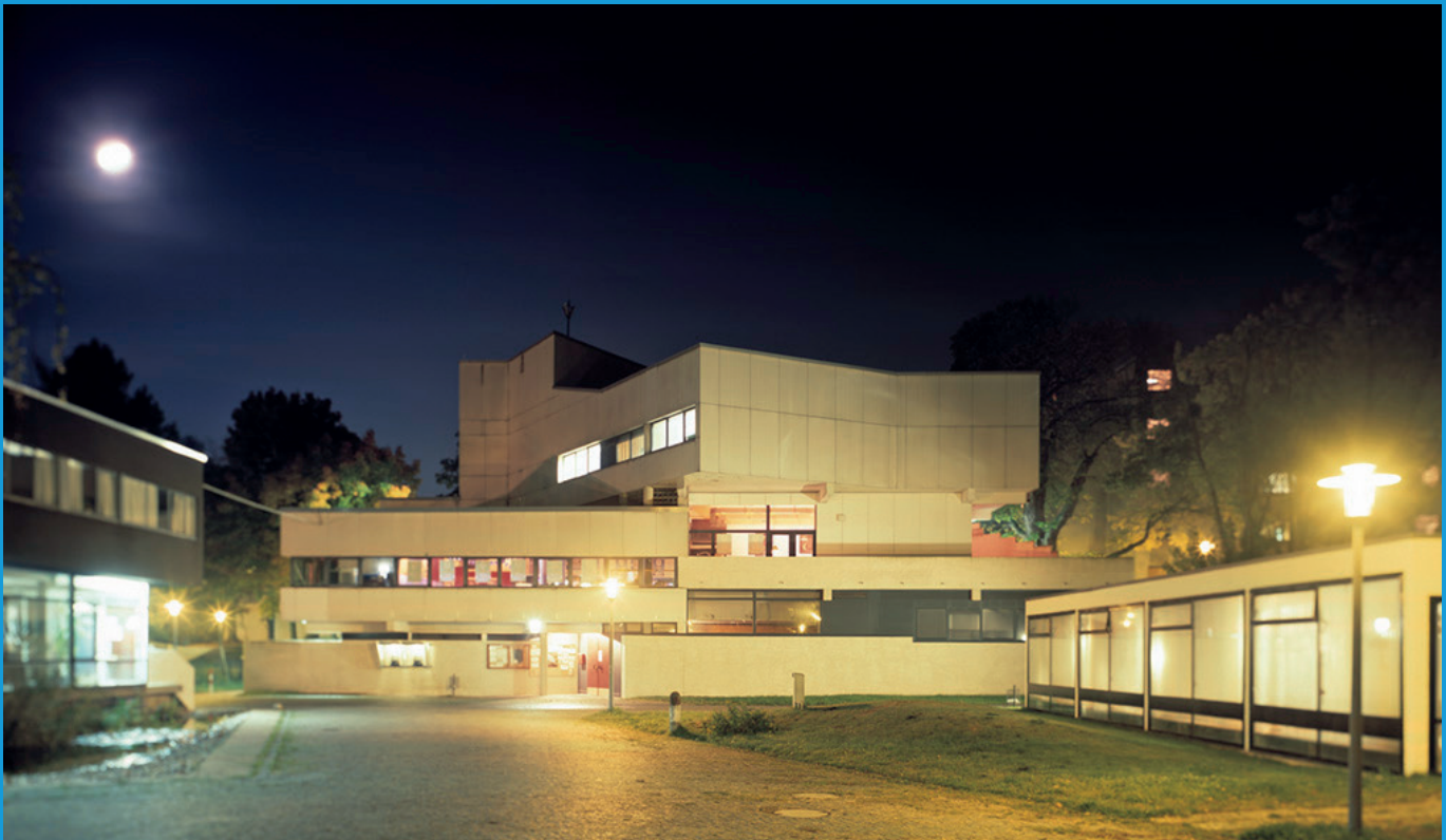
Oben: Haus 14, Ansicht Nord, 2009
